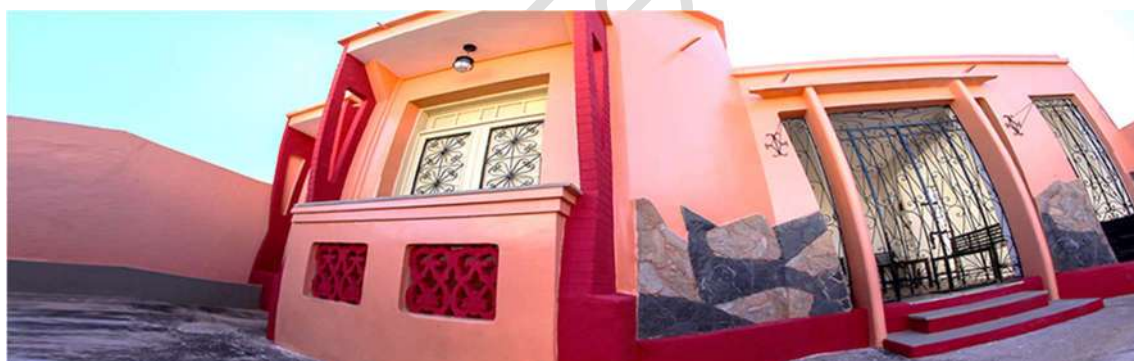
Figura 7: Fachada do prédio do Instituto Tembetá - IT.
