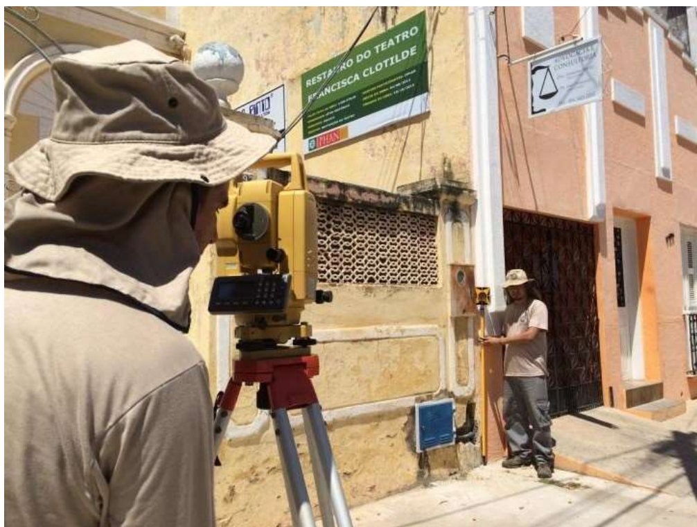
Figura 29: Pesquisa arqueológico junto às obras de restauro do Teatro Francisca Clotilde, em Aracati - CE, 2016.
