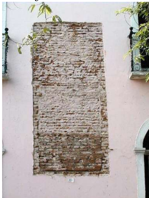
Figura 9 – Detalhe do vão aberto
