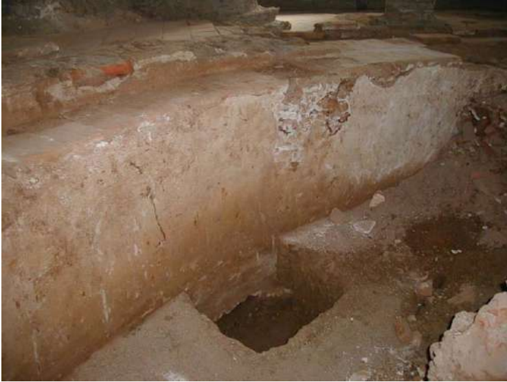
Figura 23 – Detalhe da parede de ferradura, rebocada
