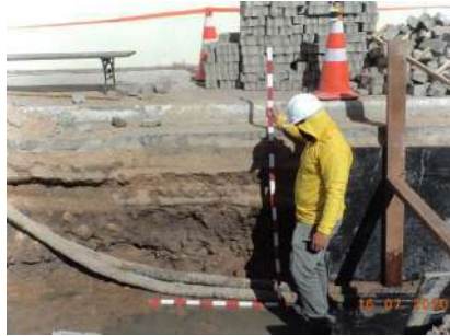
B: Camada arqueológica evidenciada entre 0,60 a 1,10 m de profundidade.
