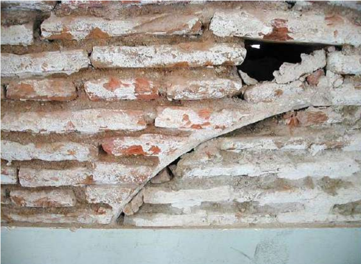
Figura 8 – Foto mostrando detalhe dos tijolos quebrados para constituir o arco
