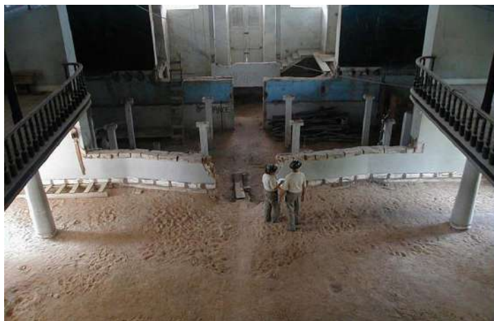
Figura 19 – Área da plateia antes das escavações
