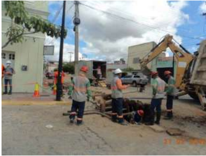
A: Contexto geral da AV em obras
