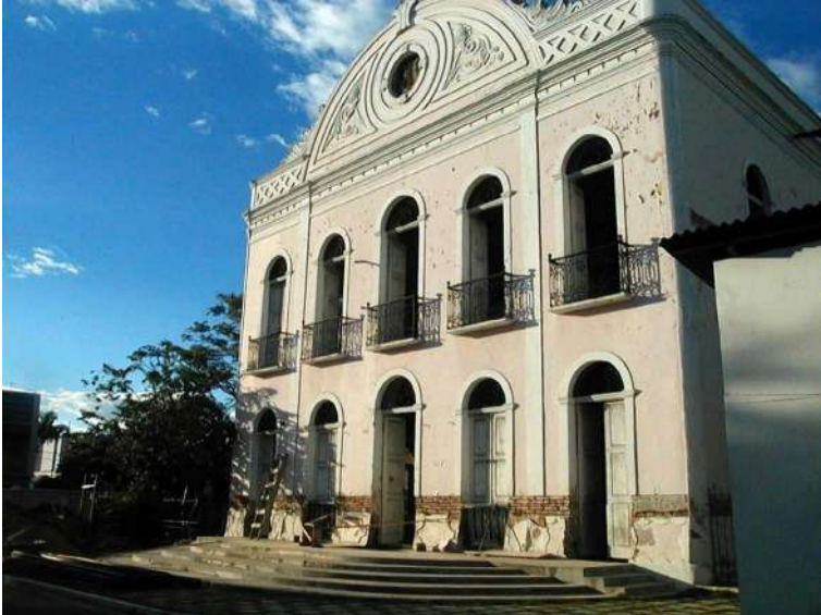
Figura 2 – Conjunto de cortes realizados na fachada principal, com vistas a avaliar-se possíveis alterações na construção
