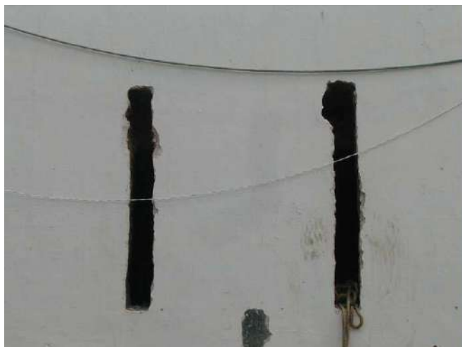
Figura 11 – Seteiras abertas com a parede rebocada
