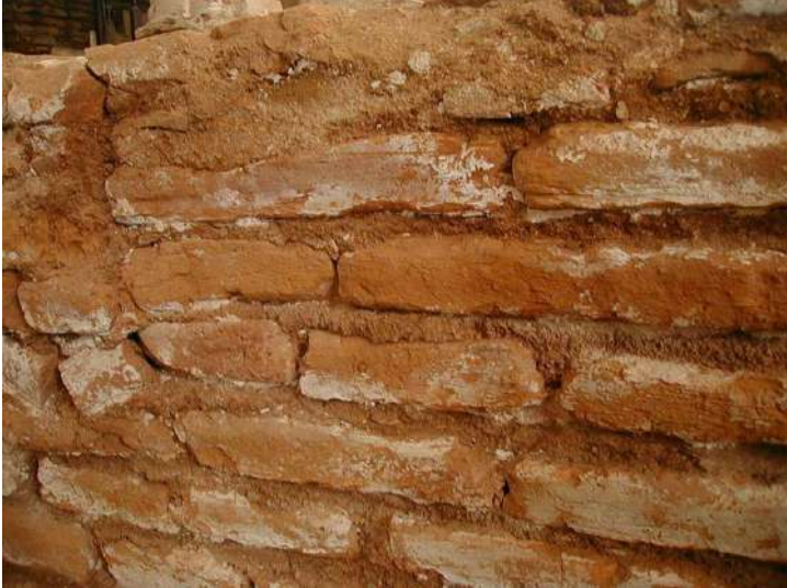
Figura 21 – Detalhe da técnica de construção, mostrando os tijolos rejuntados com barro
