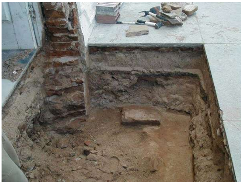
Figura 4 – Corte escavado sob a porta principal, revelando a cota do antigo piso
