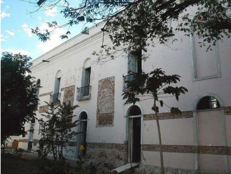
Figura 6 – Fachada lateral direita, onde simetricamente veem-se os arcos entaipados
