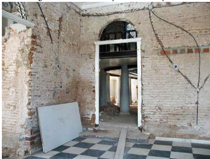
Figura 17 – Vista do hall e porta de acesso à plateia
