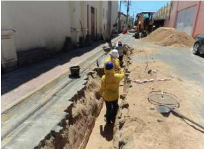
A: Contexto geral da AV em obras e pesquisa.
