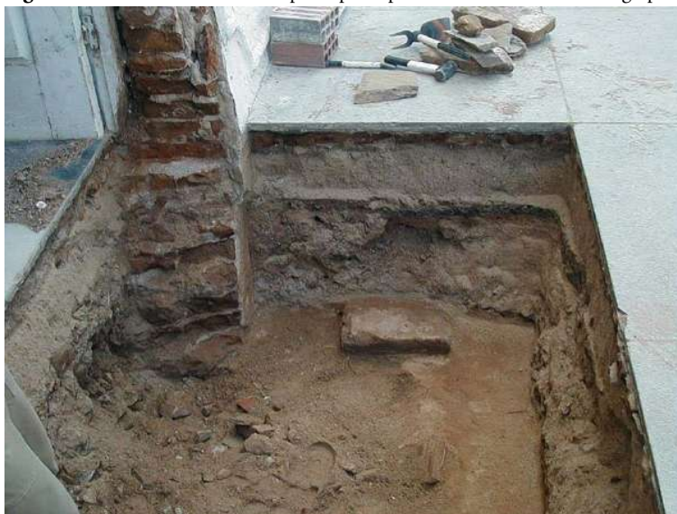
Figura 13 – Corte escavado sob a porta principal, revelando a cota do antigo piso
