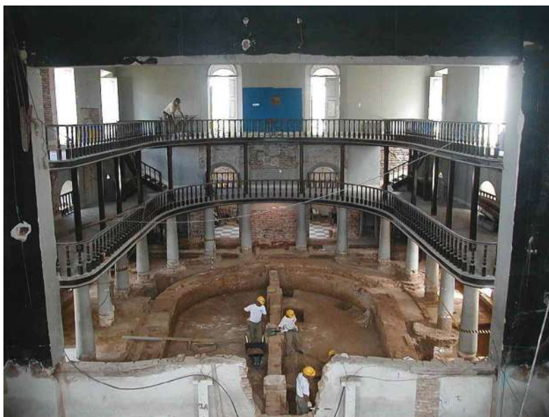
Figura 29 – Vista parcial do Teatro São João, durante as escavações
