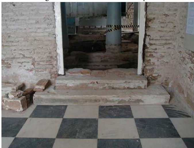
Figura 18 – Detalhe do desnível sob a porta
