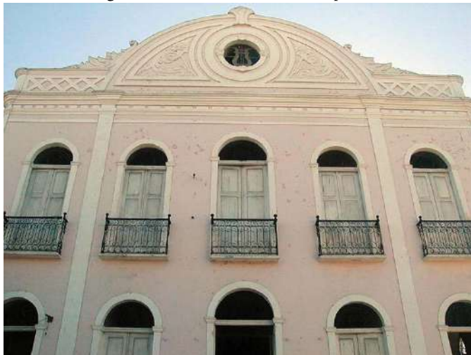
Figura 10 – Balaustradas nos vãos superiores
