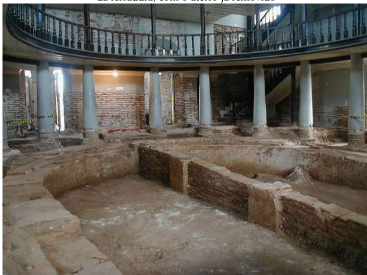
Figura 26 – Foto do conjunto das colunas no centro da ferradura, com o aterro já removido
