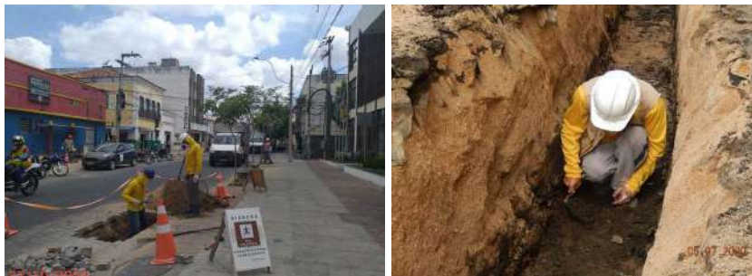
Figura 10 - A e B - Contexto da AV4 (AV5-T9) em procedimentos de investigação em nível arqueológico com a estrutura de antiga pavimentação em diferentes pontos
