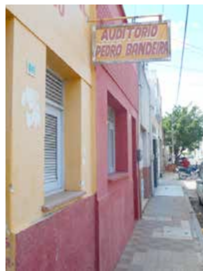
Fig. 04 : Detalhe da fachada do Auditório
