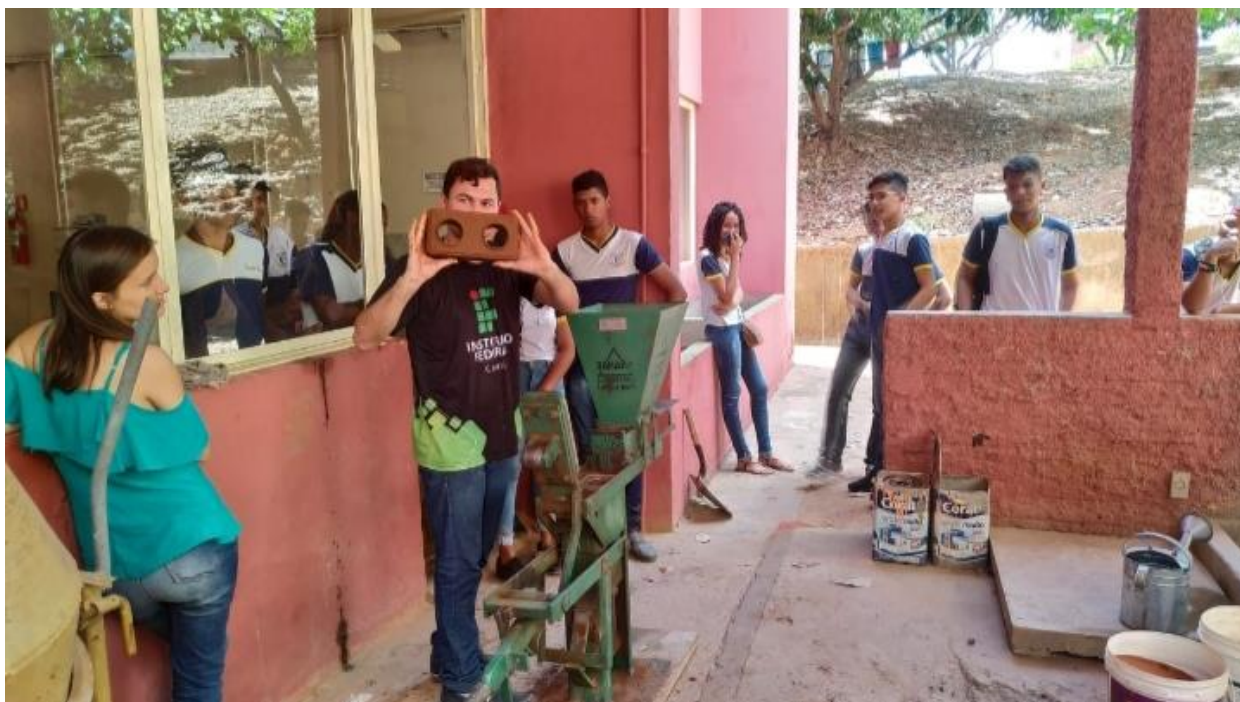
Figura 3: Desforma do tijolo Ecológico no campus IFCE-Juazeiro do Norte-CE
