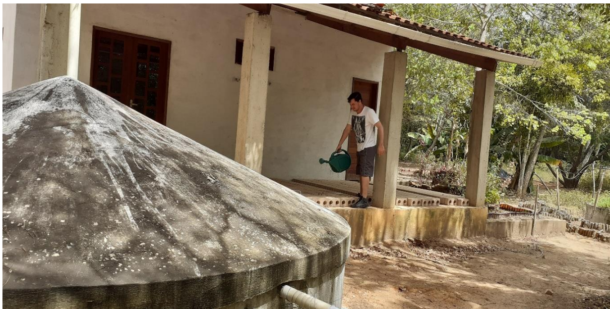
Figura 5: Hidrocure por Regador nos tijolos ecológicos por 7 dias (ABNT).
