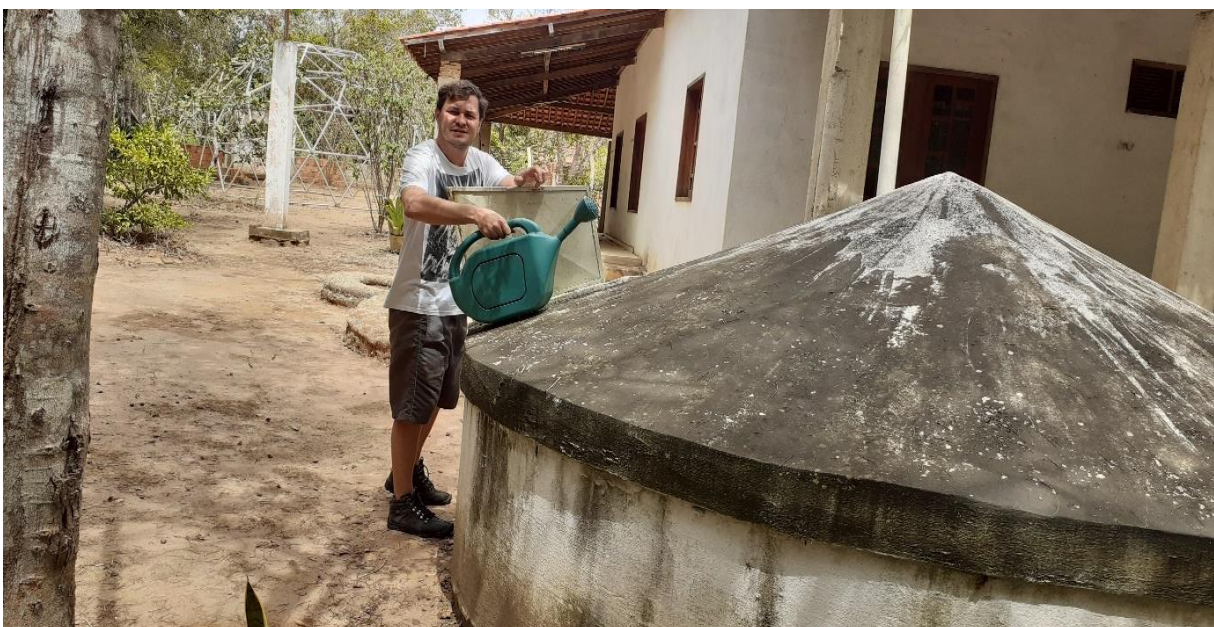
Figura 4: Armazenamento de água por meio de cisterna 1 para a hidrocura do Tijolo ecológico.
