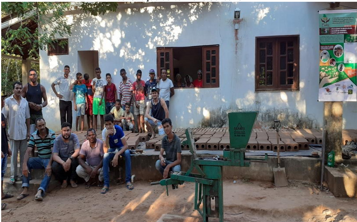
Figura 3: Comunidade do Sítio Santo Antônio- Crato CE na produção dos Biotijolos para a construção do banheiro Solidário.
