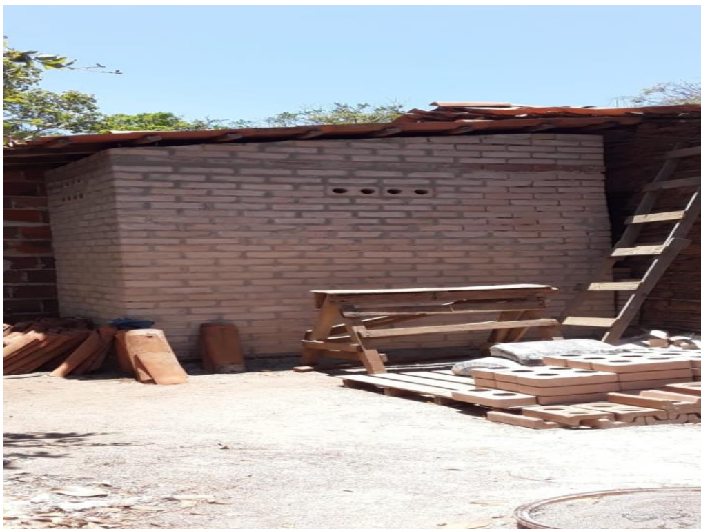
Figura 7: Banheiro solidário na casa construído
