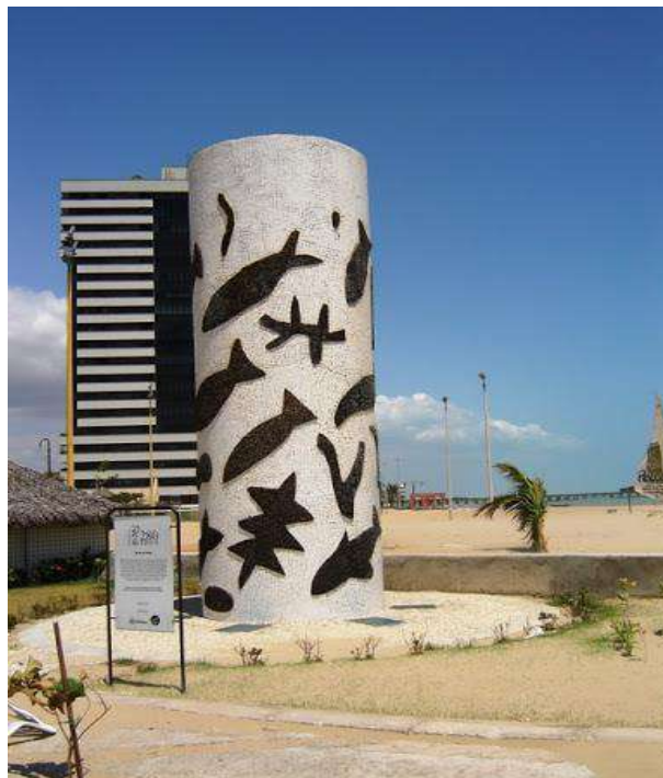
Figura 43 – Caixa d'água dos peixinhos
