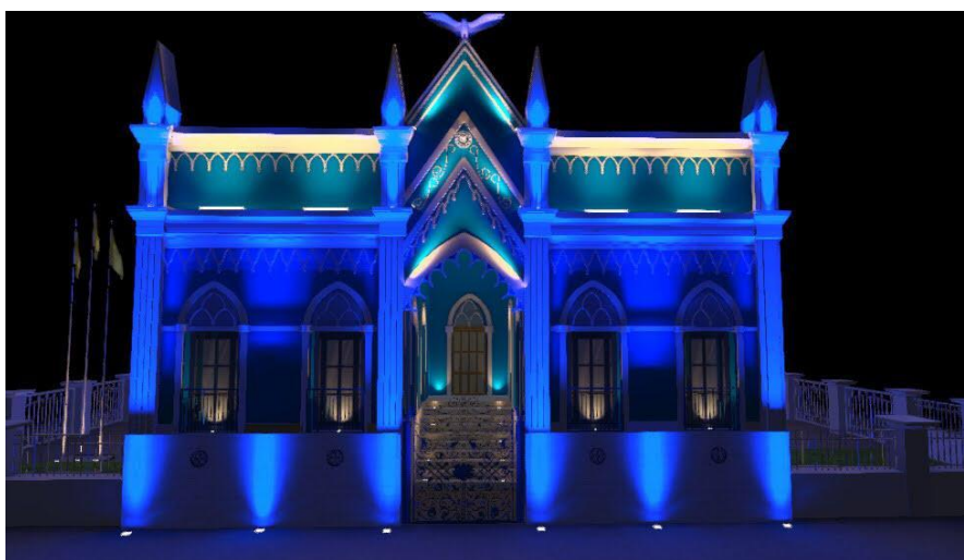
Foto 8: Perspectiva da fachada da nova sede FMAC (Fonte: FMAC)
