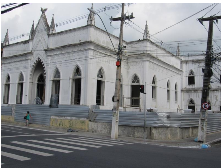
Foto 6: Fachada lateral Intendência Municipal (nova sede FMAC)
