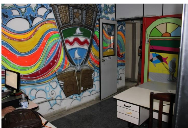
Foto 3: Sala de reuniões e as patologias do local
