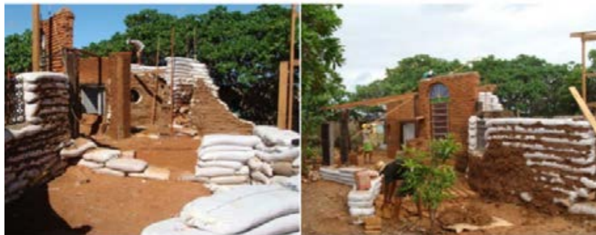
Imagens da construção da aldeia da luz em junho de 2010
