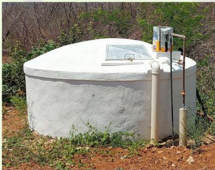
Cisterna de ferro cimento
