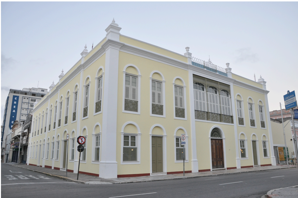
Fachada pós restauro
