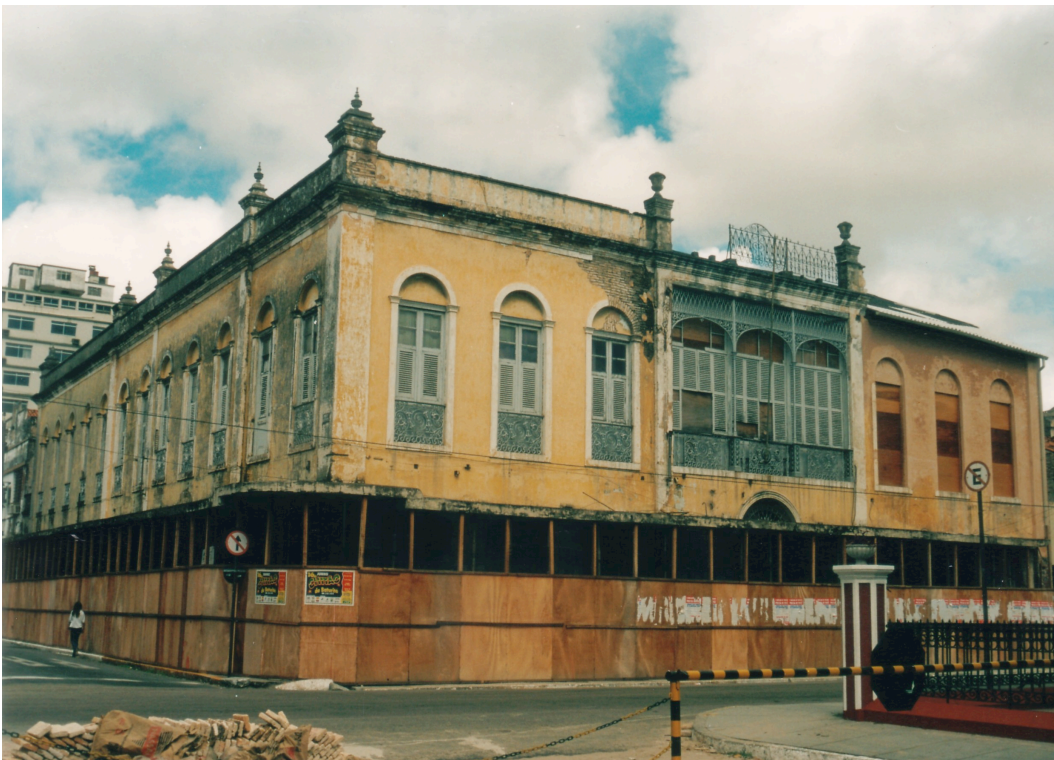
Fachada antes do restauro
